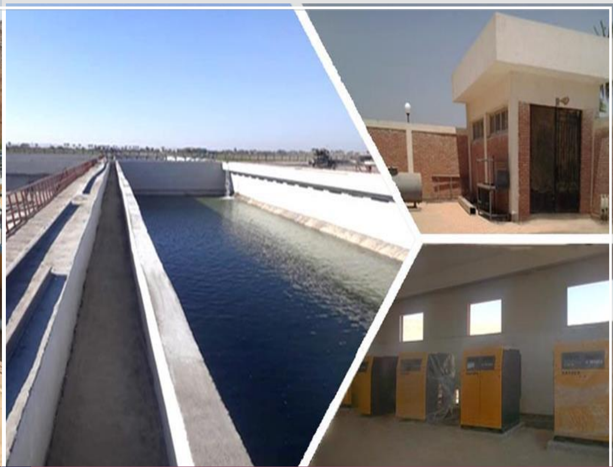
إنشاء محطات معالجة الصرف الصحي بمحافظة سوهاج
