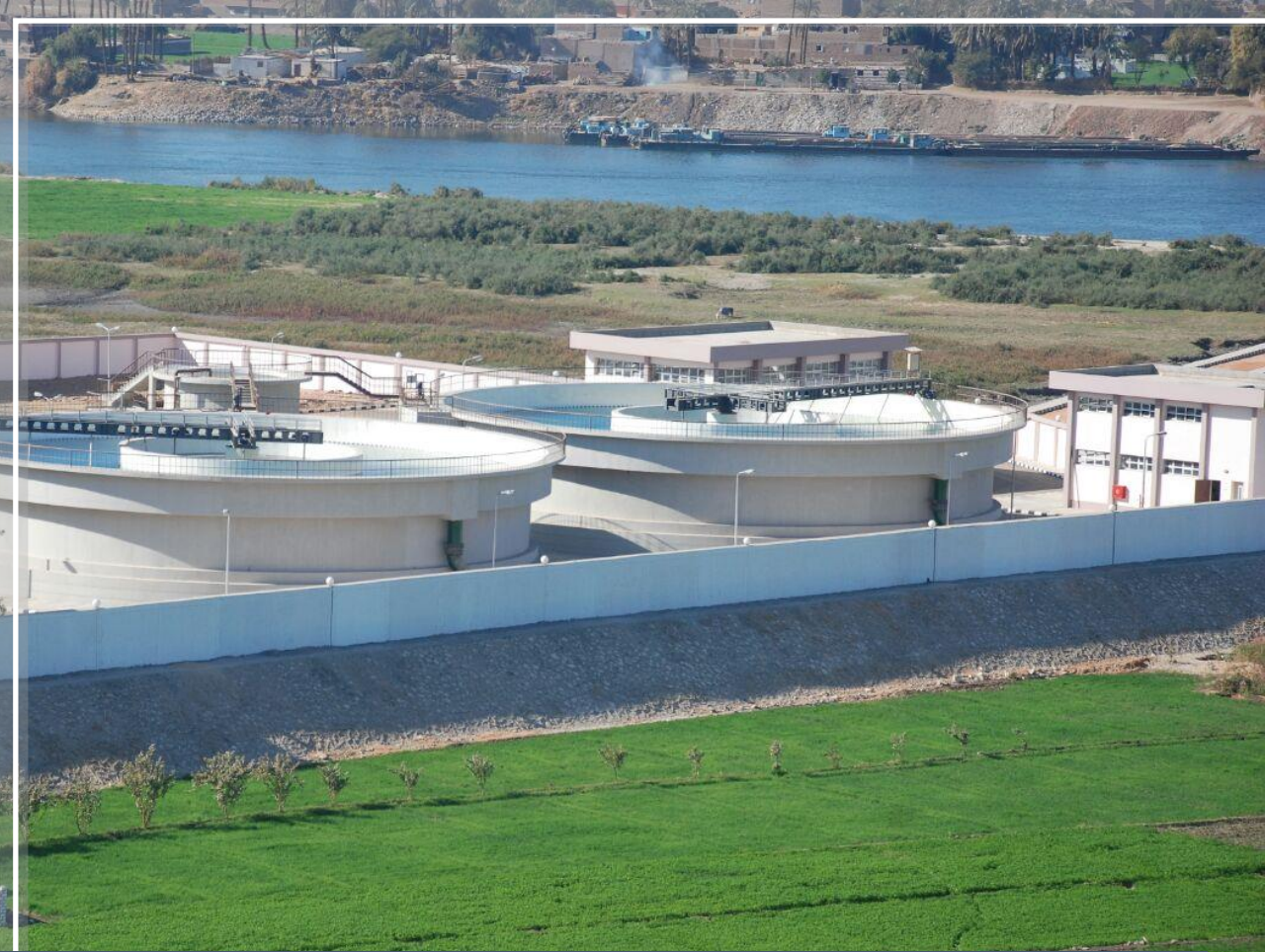
محطة تنقية مياه الشرب بالوليدية - محافظة أسيوط
