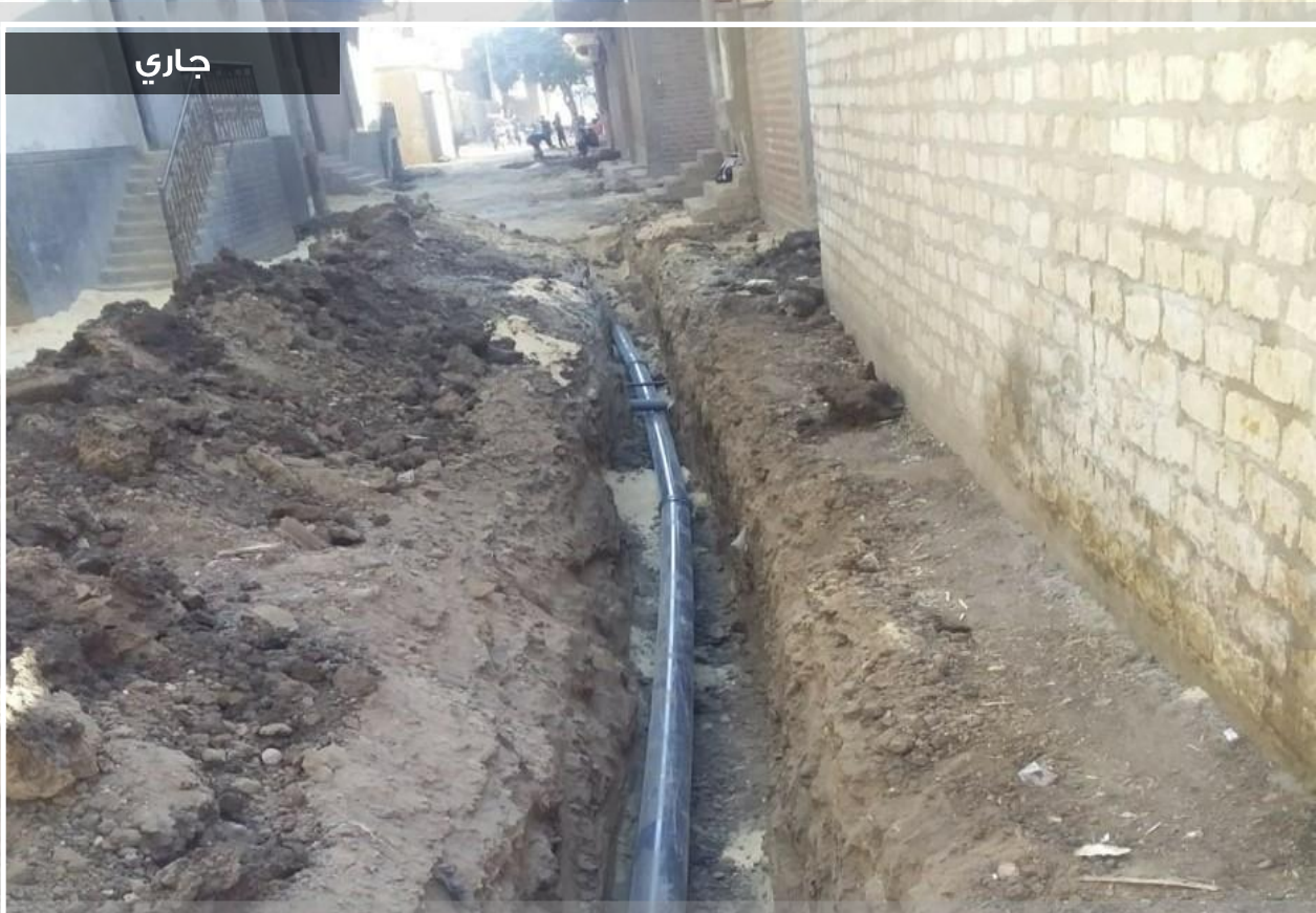
احلال شبكات مياه الشرب اسيوط
